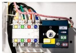
**Système permettant le démarrage automatique en cas de coupure d'alimentation.**
